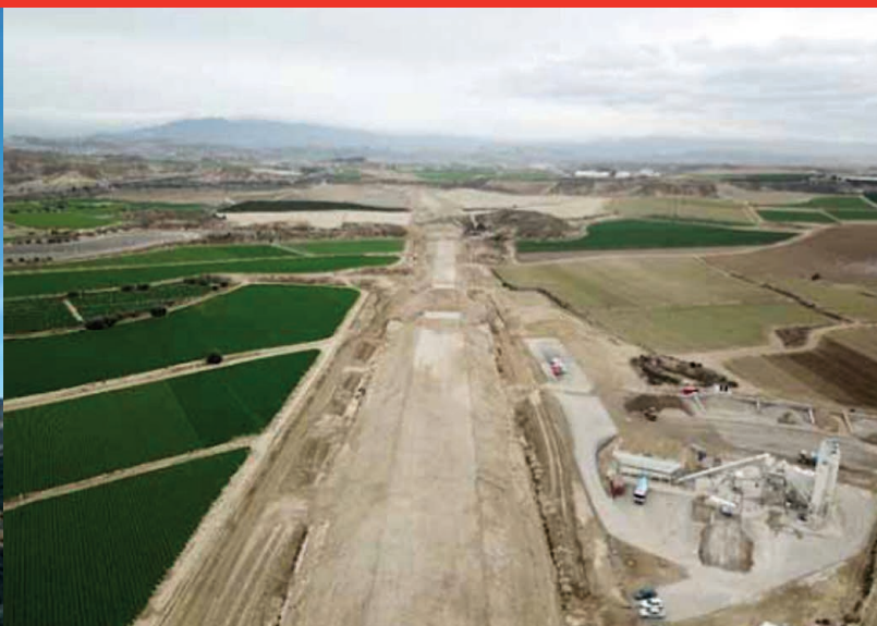
Construcción del viaducto de Los Feos, en el tramo Los Arejos-Níjar; y obras de relleno de formación de terraplén en el tramo Pulpí-Vera. Abajo, ejecución de los pozos de tratamiento en el Túnel de Viator, del tramo Níjar-Río Andarax.
